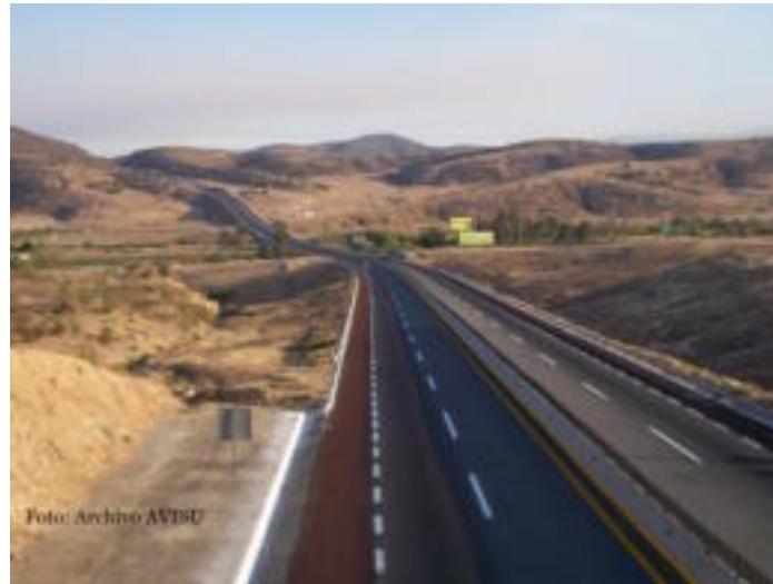
Foto 1. Autopista de cuota Cuacnopalan-Tehuacán tramo Suchilquitongo
