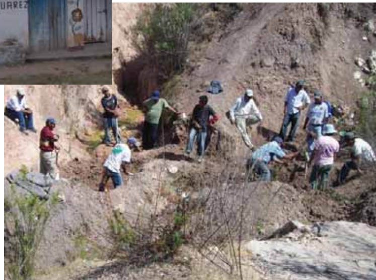
Trabajos comunitarios en búsqueda de agua
