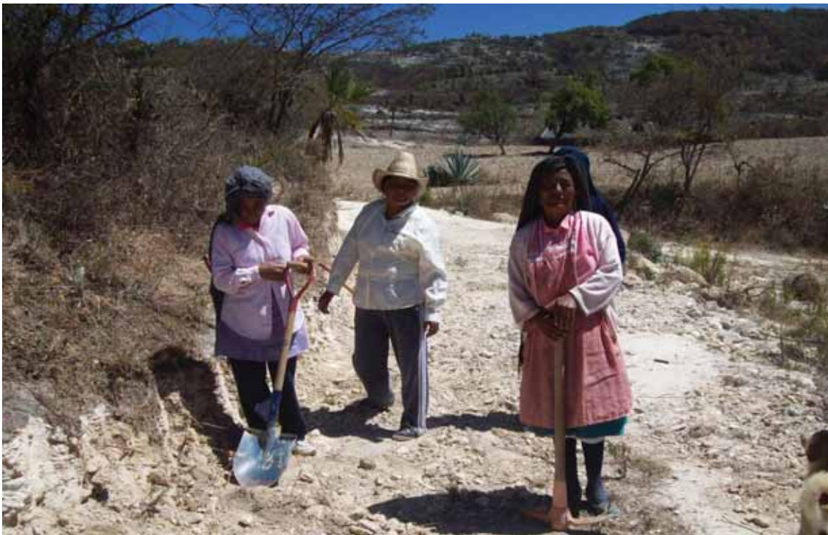
Trabajos comunitarios para apertura de caminos a falta de maquinaria
