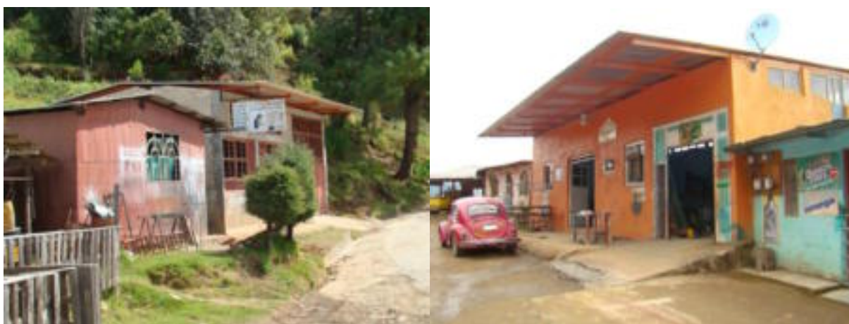
Figura 34. Balconerías de La Trinidad y Francisco I. Madero
