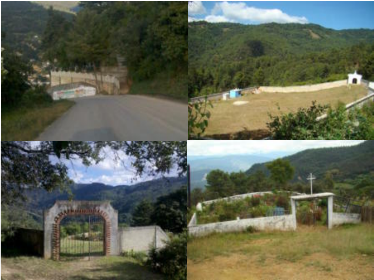
Figura 41. Infraestructura de panteones del municipio
