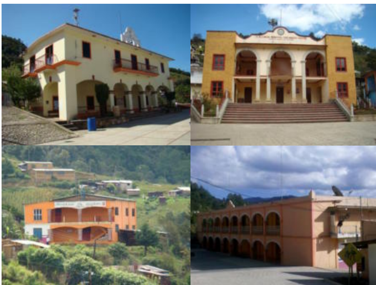
Figura 39. Estado actual de los edificios del Ayuntamiento y agencias
