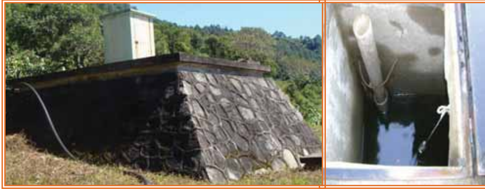
Figura 7. Tanques de almacenamiento de agua para uso humano
