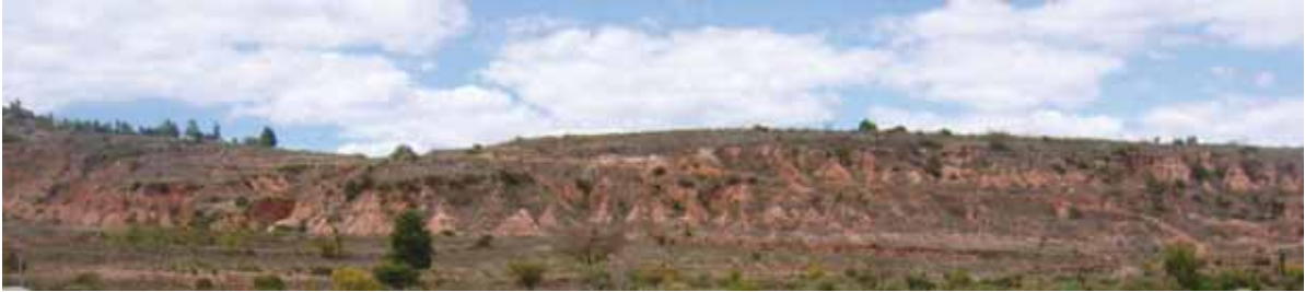
ZONA EROSIONADA EN LA PARTE SUR ESTE DE LA POBLACIÓN
