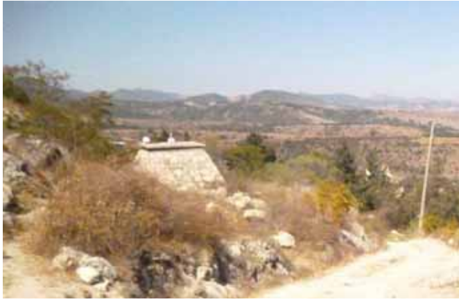
TANQUE DE AGUA POTABLE. UBICADO LADO OESTE DEL MUNICIPIO
