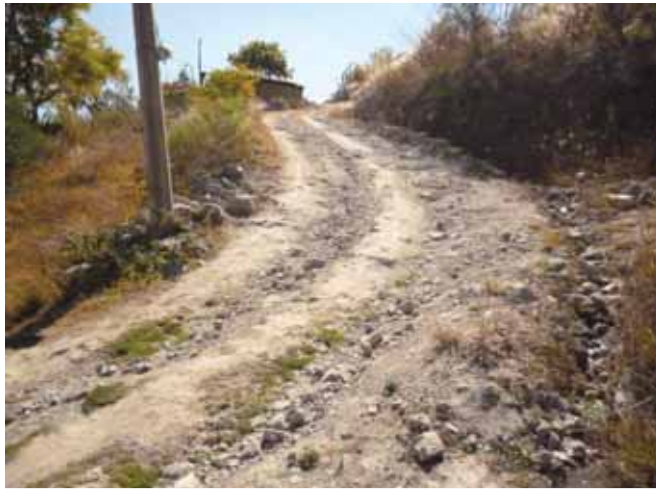
CALLES DE TERRACERIA SIN MANTENIMIENTO
