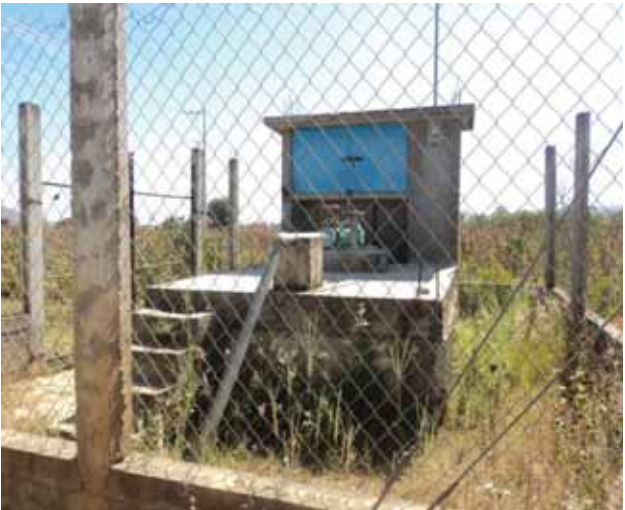
Fotografía 8.- Pozo de agua potable Santa María Róalo.
