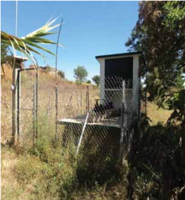
Fotografía.- 7 pozo de agua potable tlanichico.
