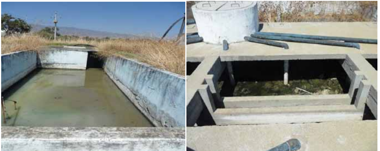
Fotografía 5.- Planta de tratamiento de aguas residuales y negras.
