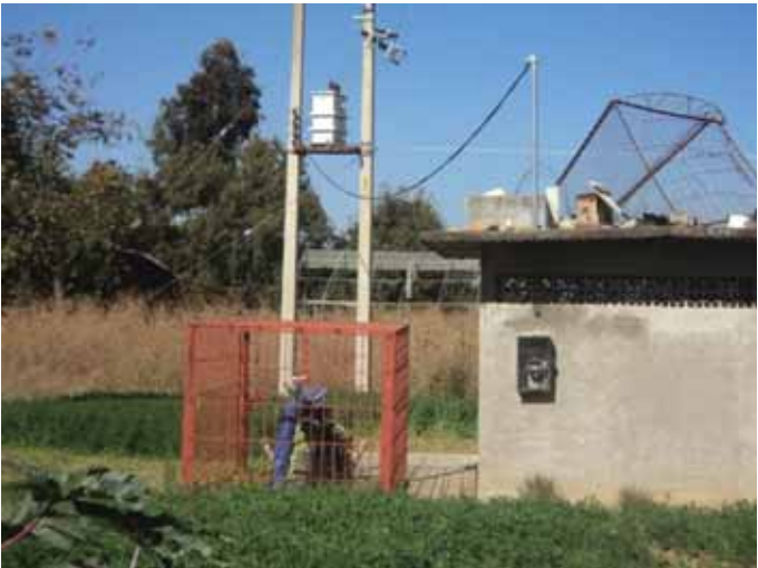
Fotografía 9.- Pozo unidad de riego cabecera mpal
