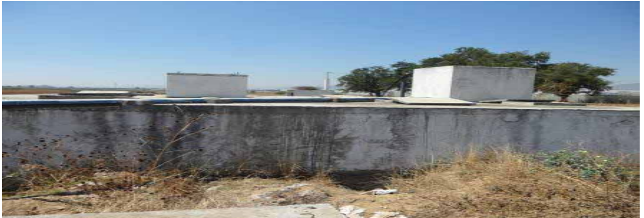
Fotografía 4.- Planta de tratamiento
