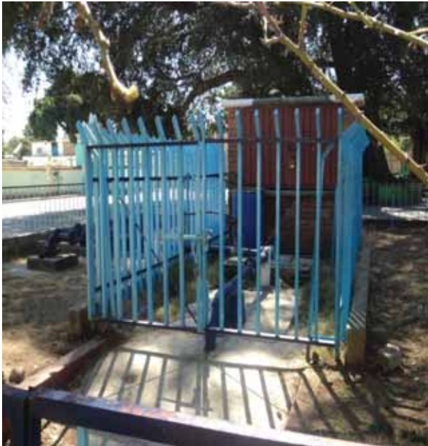
Fotografía 6.- pozo de agua potable cabecera mpal.
