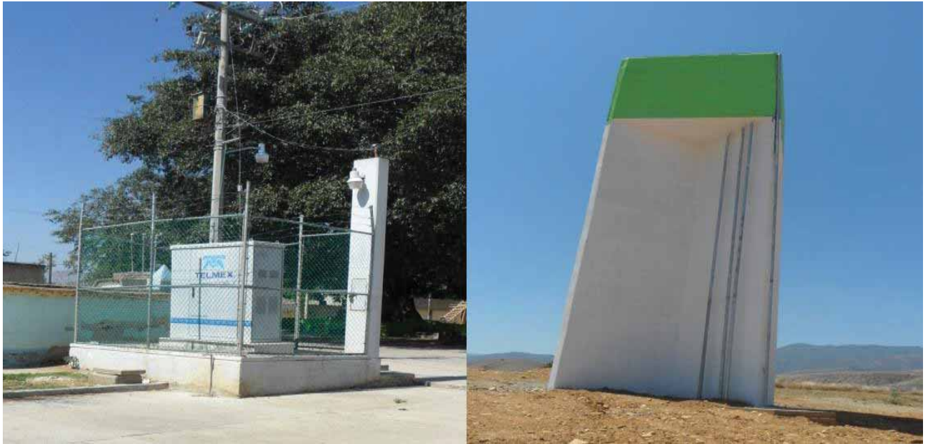
Fotografía 2.- Fuente de abastecimiento y tanque de distribución.
