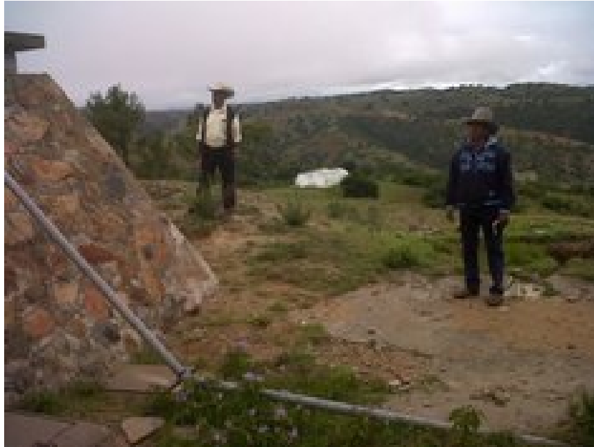
*Tanque de almacenamiento de agua en la agencia La Paz Zaragoza
