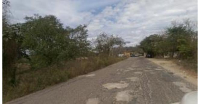
*Imagen 2. Pavimento desgastado y baches en la carpeta asfáltica
