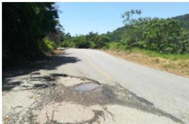
*Imagen 3. La superficie de la vialidad es de pavimento asfáltico. Pavimento desgastado, con hundimientos y baches
