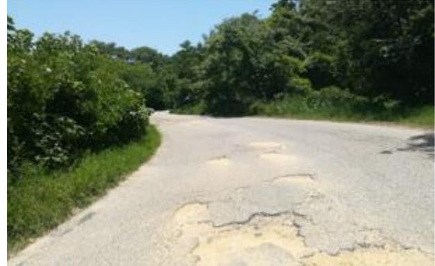
*Imagen 10. La superficie de la vialidad es de pavimento asfáltico desgastado y con hundimientos que disminuyen la velocidad*
