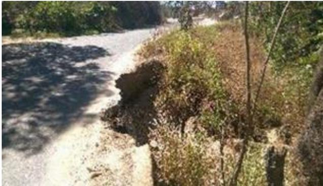
*Imagen 23. Deslaves por falta de muros de contención reduciendo el espacio de circulación
