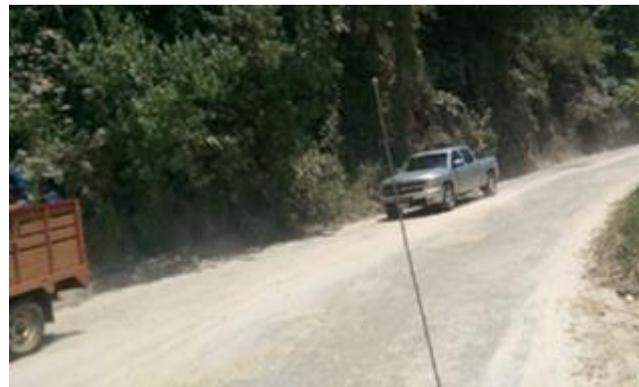
*Imagen 12. Pavimento desgastado con baches que disminuyen la velocidad de vehículos*
