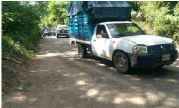
*Imagen 29. Pavimento desgastado y falta de delimitación de carriles ocasionan congestionamiento
