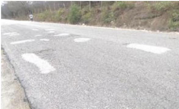
*Imagen 27. Pavimento desgastado con baches que disminuyen la velocidad de vehículos
