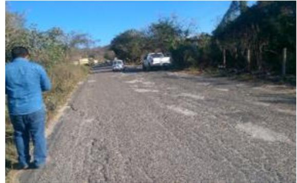
*Imagen 30. Pavimento desgastado con baches que disminuyen la velocidad de vehículos
