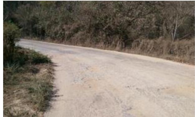
*Imagen 14. Pavimento desgastado con baches que disminuyen la velocidad de vehículos
