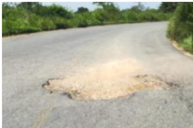
*Imagen 1. La superficie de la vialidad es de pavimento asfáltico. Pavimento desgastado y con hundimientos que disminuyen el paso de vehículos
