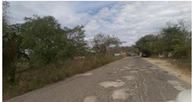
*Imagen 28. Pavimento desgastado con baches que disminuyen la velocidad de vehículos
