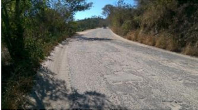
*Imagen 17. Pavimento desgastado con baches que disminuyen la velocidad de vehículos*
