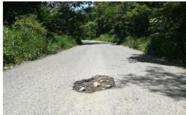
*Imagen 8. Pavimento desgastado con baches que disminuyen la velocidad de vehículos*
