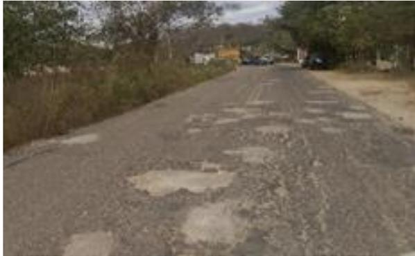
*Imagen 1. Baches en la carpeta asfáltica
