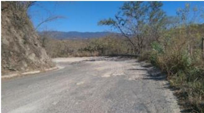
*Imagen 19. Pavimento desgastado con baches que disminuyen la velocidad de vehículos*
