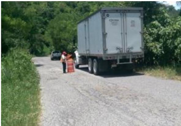
*Imagen 7. Pavimento desgastado con baches que disminuyen la velocidad de vehículos*
