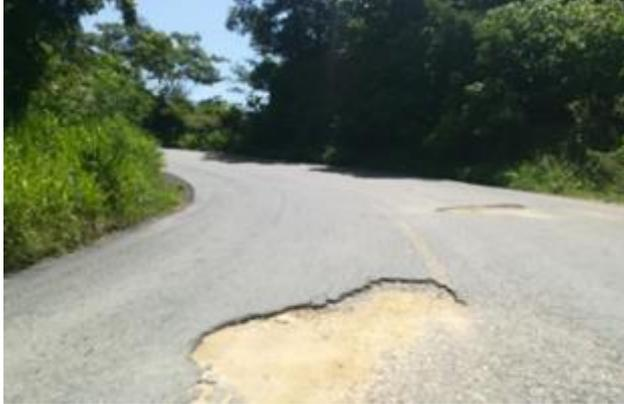
*Imagen 5. La superficie de la vialidad es de pavimento asfáltico desgastado y con hundimientos que disminuyen la velocidad*
