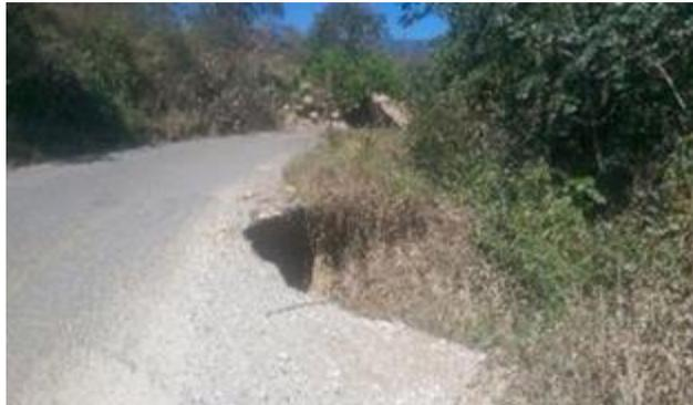
*Imagen 13. Deslaves por falta de muros de contención reduciendo el espacio de circulación
