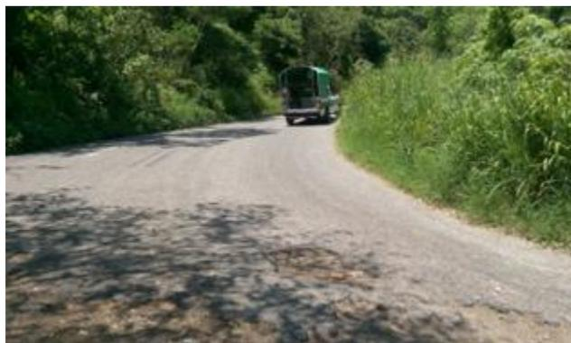
*Imagen 4. Pavimento desgastado con baches que disminuyen la velocidad de vehículos
