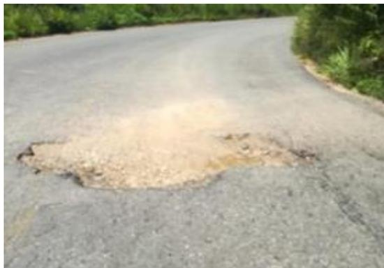
*Imagen 1. Deformación de superficie
