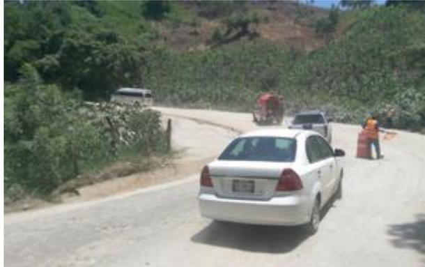
*Imagen 21. Pavimento desgastado y falta de delimitación de carriles disminuyen la velocidad de vehículos
