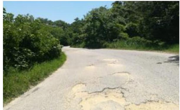
*Imagen 2. Pavimento desgastado y baches en la carpeta asfáltica*
