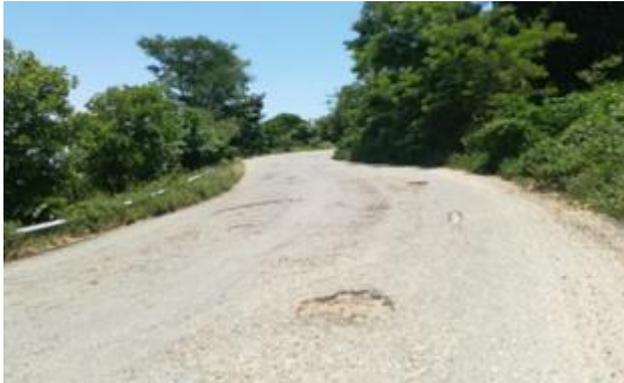
*Imagen 9. Pavimento desgastado con baches que disminuyen la velocidad de vehículos*
