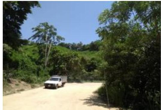
*Imagen 20. Pavimento desgastado y falta de delimitación de carriles disminuyen la velocidad de vehículos*
