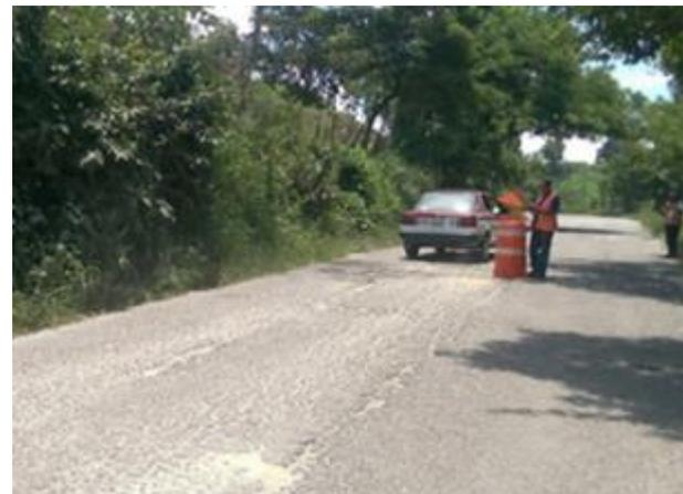
*Imagen 16. Pavimento desgastado y sin señalética horizontal que disminuyen la velocidad de vehículos
