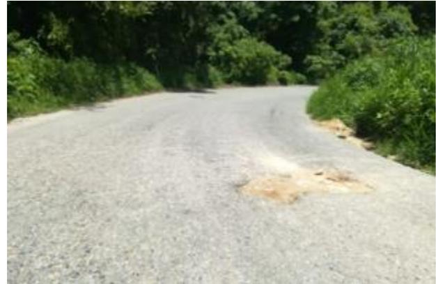
*Imagen 6. La superficie de la vialidad es de pavimento asfáltico. Pavimento desgastado y con hundimientos que disminuyen el paso de vehículos*
