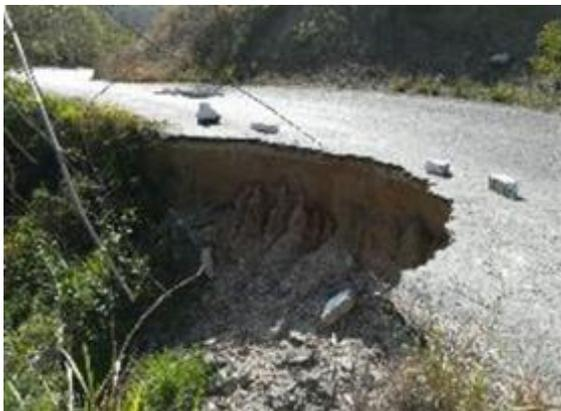
*Imagen 11. Deslaves por falta de muros de contención reduciendo el espacio de circulación*
