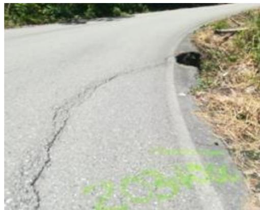
*Imagen 2. La superficie de la vialidad es de pavimento asfáltico desgastado, presenta cuarteaduras
