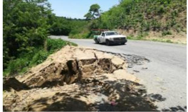
*Imagen 18. Deslaves por falta de muros de contención reduciendo el espacio de circulación*
