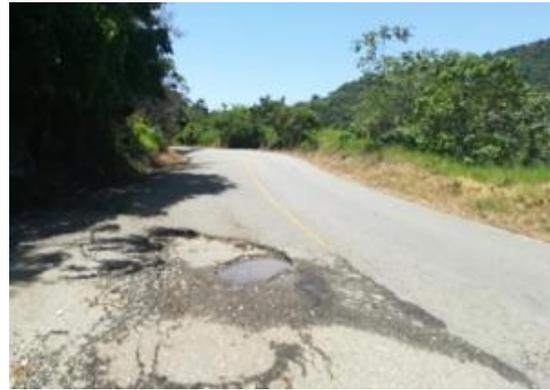
*Imagen 4. Pavimento desgastado, baches y falta de delimitación de carriles
