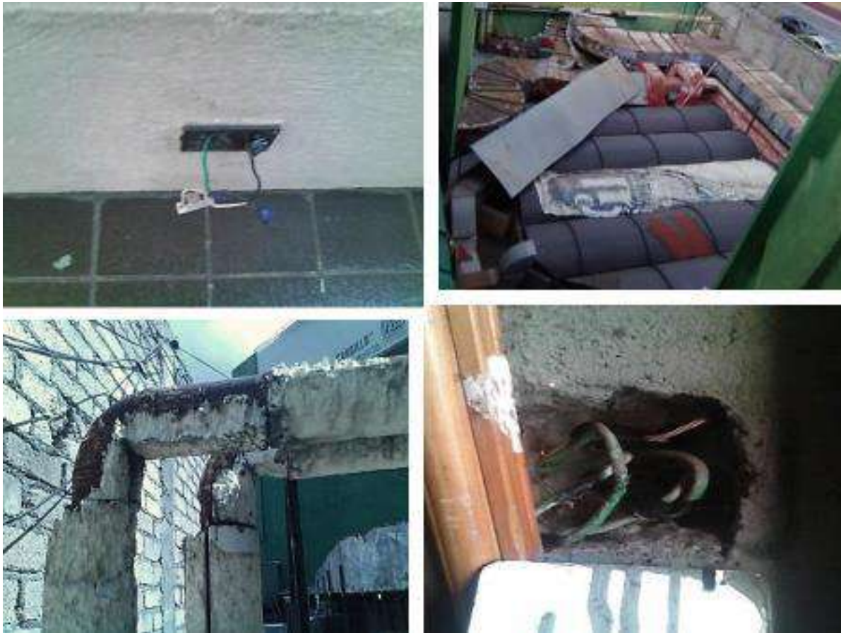
Figura 18. Situación del Teatro Álvaro Carrillo antes de ser demolido (áreas exteriores)
