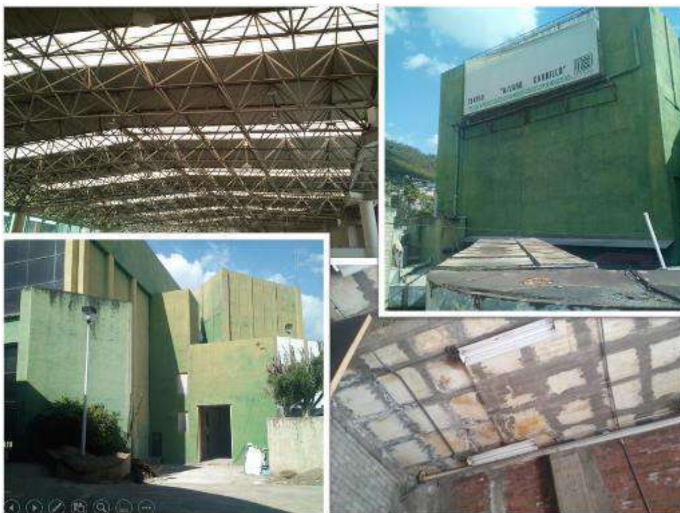
Figura 17. Situación del Teatro Álvaro Carrillo antes de ser demolido (techumbre y fachadas)
